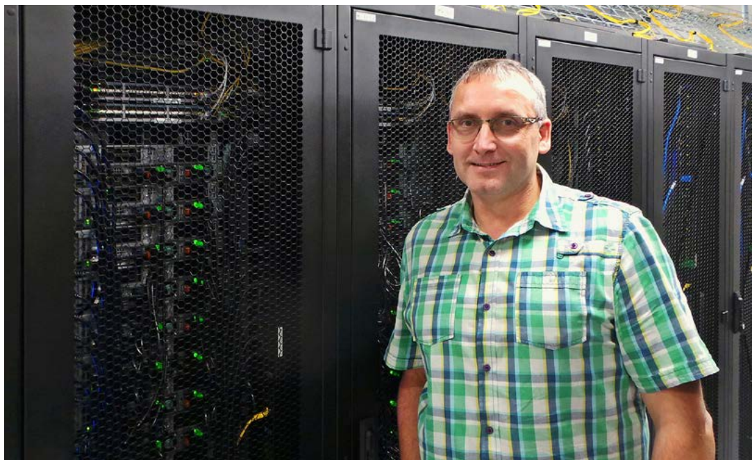
Datacentrem TH Brno nás provedl Karel Badin, provozní ředitel itself s.r.o.
